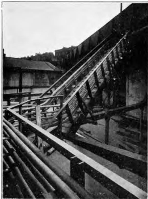
FIG. 3.—STEEL CABLE RAMP.
