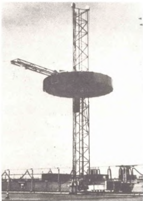
Sostegno mobile con tamburo porta-apparecchi di illuminazione Philips posto a 10 m di altezza.
