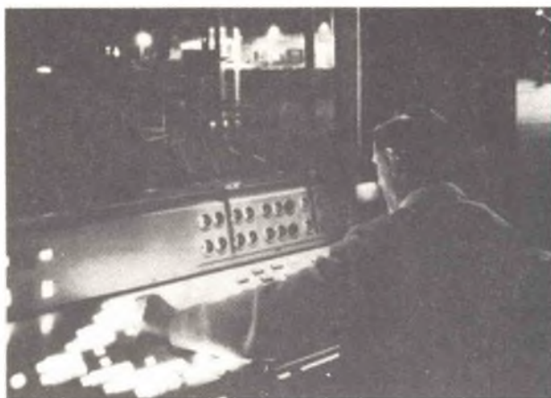
Pannello delle apparecchiature installate nel posto di controllo del laboratorio Philips.
