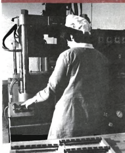
Fig. 5 - Una serie del primo dispositivo in plastica della G.I., l'AY-1-5050, all'uscita dalle presse.
