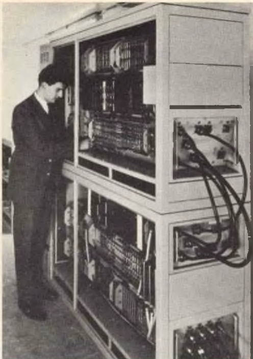
Un calcolatore numerico AEI 959 in corso di installazione allo stabilimento di Corby della società Stewarts & Lloyds Ltd., per il controllo sulla linea di produzione della cesoia volante.
