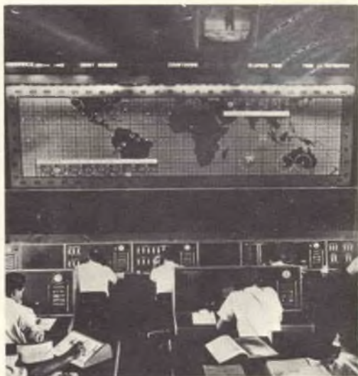
La Sala di Controllo Operativo del Centro Mercury, installata a Cape Canaveral, fornisce agli operatori ed ai monitor i dati essenziali sull'andamento della missione. Una carta geografica generale illustra le posizioni della capsula lungo i percorsi orbitali; i cerchi bianchi indicano le varie stazioni di controllo.
