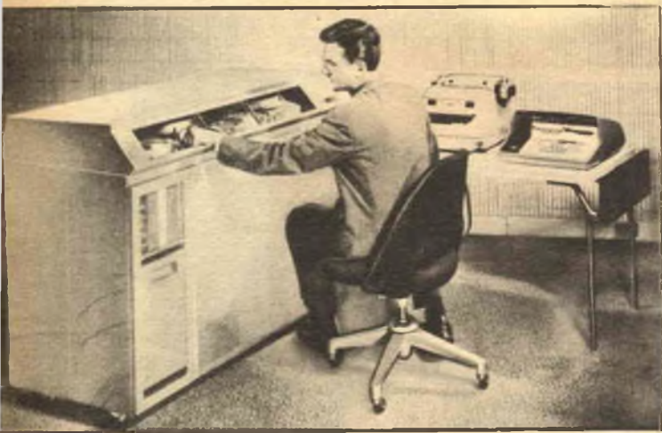
Questa macchina di controllo digital ha funzioni umane: controlla automaticamente i processi di fabbricazione.
