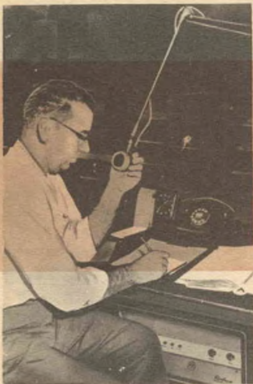
Installazione della RCA per sistema di comunicazioni radio bilaterali in una dilta di trasporti. - A sinistra: lo spedizioniere comunica con uno degli autocarri in sosta d'attesa per nuova destinazione.
