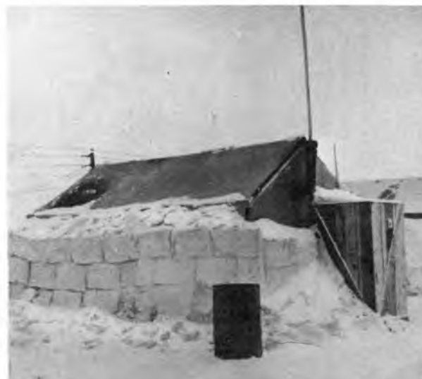
(Sotto). Imitando gli Eschimesi, le costruzioni vengono protette da blocchi di ghiaccio, per diminuire la dispersione di calore.
