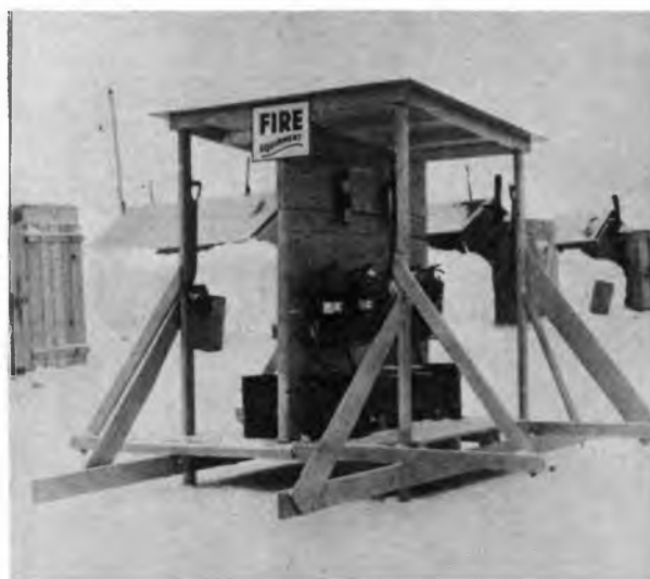
(Sopra). Una stazione antincendio, con estintori chimici, sistemata tra le unità. L'aria secca ed il forte vento sono causa di grave pericolo di incendio nelle zone artiche.
