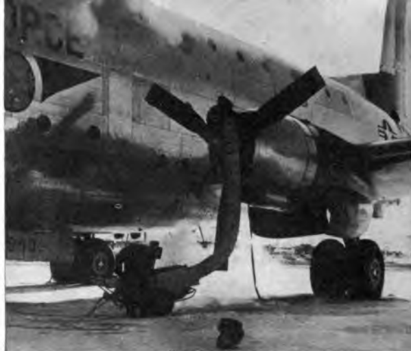
L'amico più prezioso nell'artico è il riscaldatore Herman-Nelson. Un riscaldatore di questo tipo disgela il motore di un C-124.
