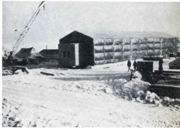
(Sopra). Le unità più grandi sono montate nelle aride zone del Canada, dove vengono ricoperte di speciali teli isolanti.
