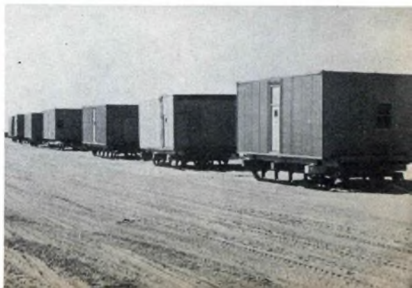
(Sotto). Montate su slitte le unità vengono trainate da trattori attraverso le zone gelate dell'Alaska. Misurano 4,5 m x 8 m e sono alte 3 m.
