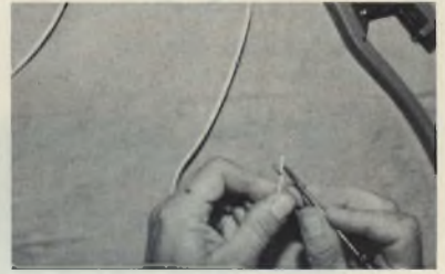
Si « apre » la spirale con una punta dividendola dal conduttore interno.
