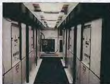
4 - Une vue de l'intérieur des installations.
