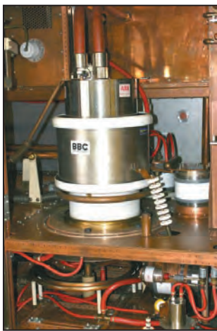
7 - Comment passer de 1 kW à 500 kW !
