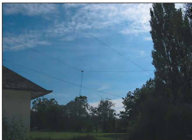
1 - Sur cette photo, volontairement contrastée afin de faire apparaître les fils d'antenne, on voit : au loin, la center-fed, au milieu la CW3, le dernier fil (proche du premier plan) étant un simple hauban.
