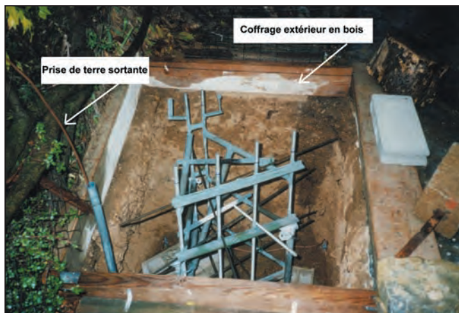
Photo n° 10 : Chaise prête à être coulée.
