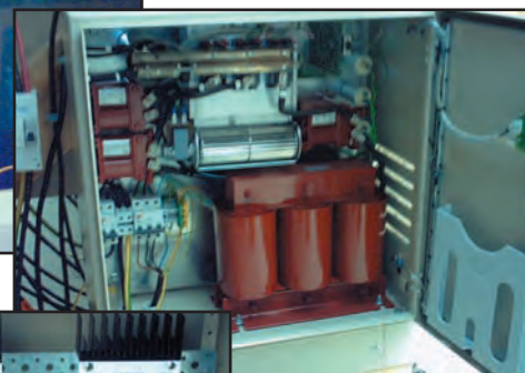
5 et 6 - Le câblage de l'installation.
