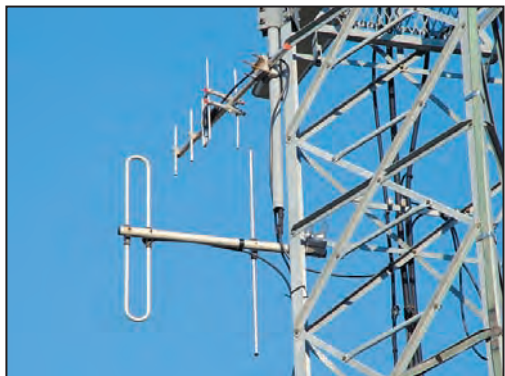
Détail des antennes à Battaglia.
