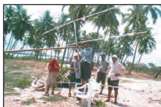
Assemblage d'une antenne.
