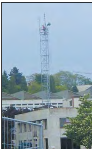
Le pylône du relais.
