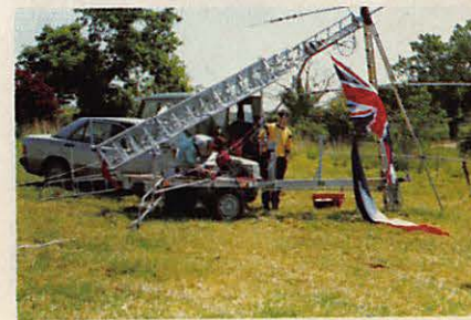
Montage et réglage du pylone.
