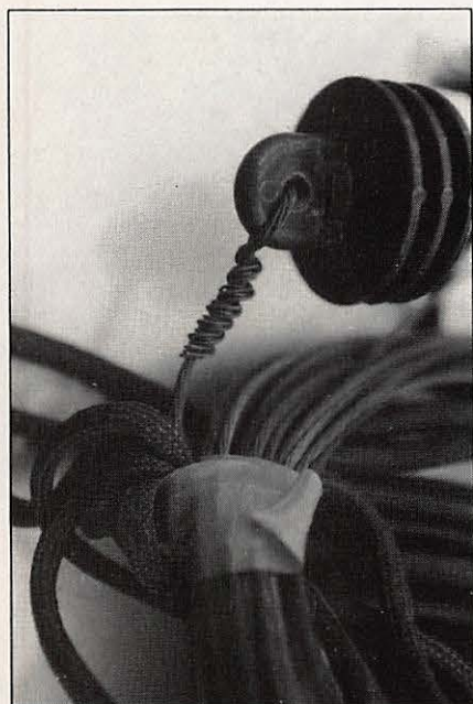
Réglage, côté extérieur, du câble rayonnant.
