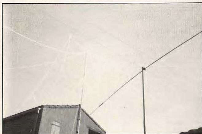
Cette magnifique toile d'araignée fut tout ce qui subsista d'une Quad deux éléments après le passage d'une tempête de neige !
