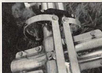
Mise en place des croisées et des deux supports de lignes.
