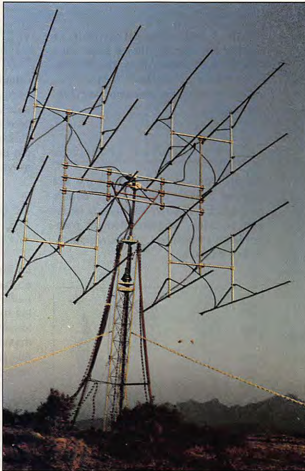
Photo 9 : Les antennes. 16 x 21 éléments TONNA.
