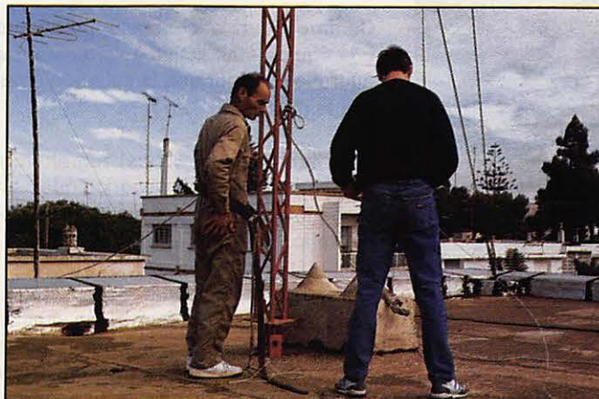
Montage des antennes : F6ATQ et F6BQY
