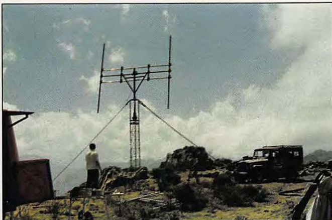
Photo 4 : La levée du pylône et du support principal.
