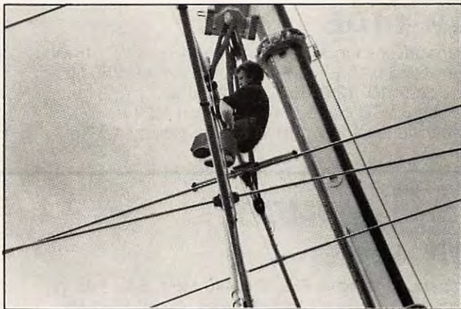
Le SWL Edmond en haut du pylône.
