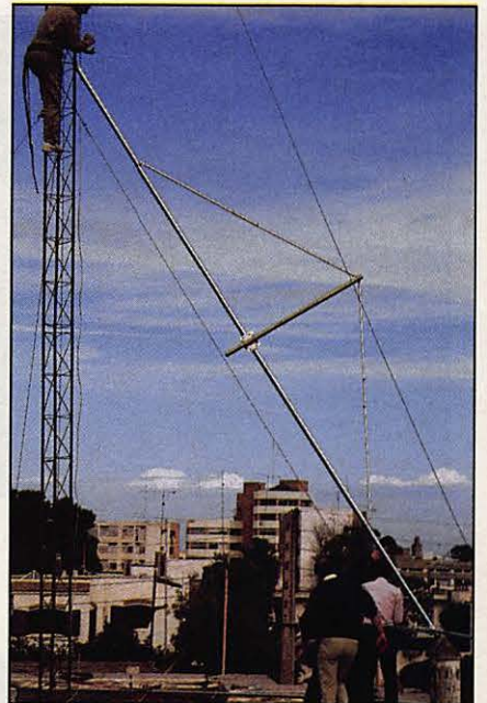
Montage de l'antenne 2 él. 40 m. En haut du pylône : F6ATQ
