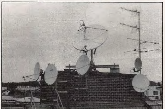
Les antennes satellite de Saditel.
