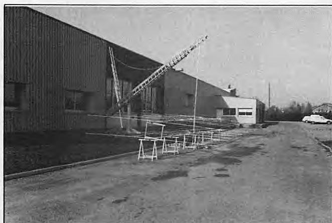
Préparation des deux antennes, l'une sur l'autre.
