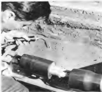
Bild 8. Die Schrumpftechnik ermöglicht, in der Erde verlegte Antennenkabel vollständig wasserdicht abzudichten
