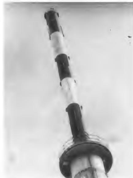
Bild 1. Die neue UHF-Antenne des Senders Brandenkopf/Schwarzwald mit axialen Drehkreuz-Viererdipolen im Innern des glasfaserverstärkten Epoxyharz-Zylinders
