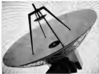
20-m-Cassegrain-Parabol unter Radom an der Sternwarte Bochum (Werkaufnahme: Rohde & Schwarz)
