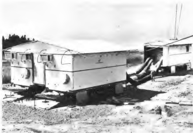
Die beiden Fahrzeuge mit dem Bild- und dem Tonsender werden nebeneinander aufgestellt. Durch Aufklappen der inneren Seitenwände und Abdichten der Vor- und Rückseite ergibt sich ein wetterfester Betriebsraum. Im Hintergrund der Lüfterwagen, der über die vier 45 cm dicken Schläuche für temperierte Umluft sorgt
