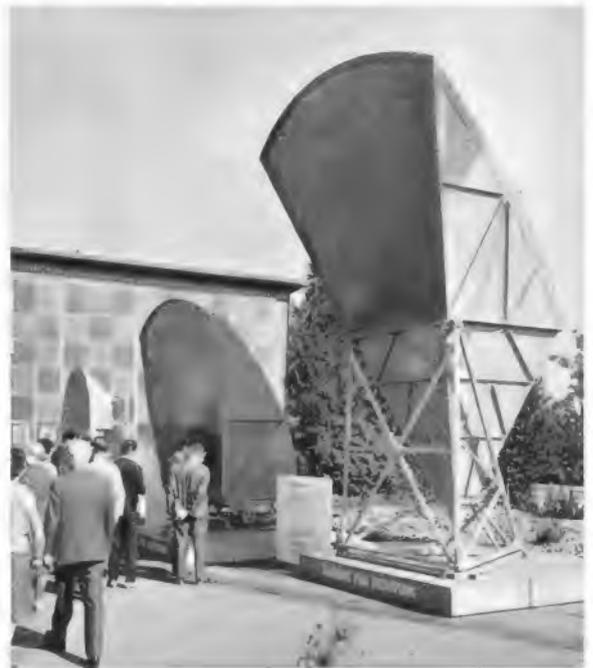
Bild 13. Richtfunkantennen an der Antennenstraße; rechts eine Hornparabolantenne, links eine neuartige mit Polyester verkleidete Muschelantenne. Die Muschelantennen lassen sich auf Richtfunktürmen enger aneinanderreihen, ohne sich gegenseitig zu beeinflussen (Foto: Stumpf)
