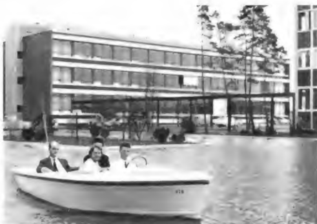
Bild 1. Brennstoffzellen, die im Erlanger Forschungszentrum der Siemens-Schuckert-Werke entwickelt wurden, treiben dieses Boot an. Reines Wasser statt Auspuffgas und völlige Geräuschlosigkeit sind die angenehmen Vorteile dieser Antriebsart
