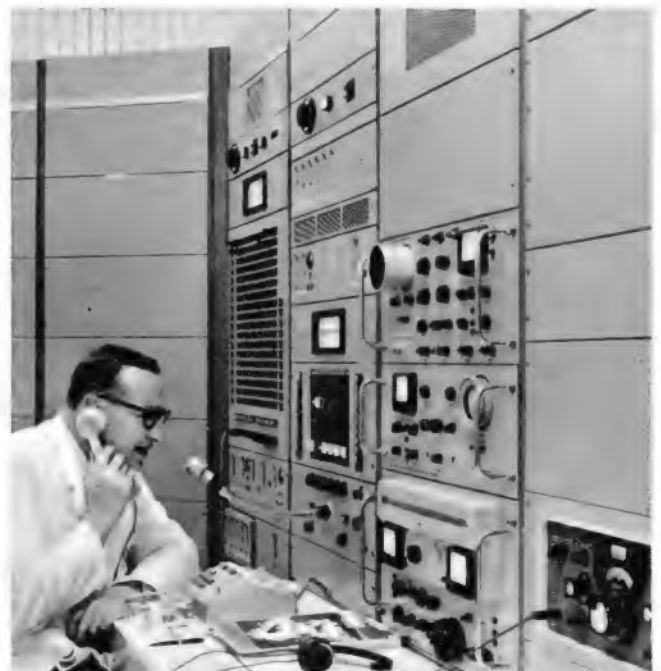
Bild 2. Einer der bisher eingerichteten drei Empfangsplätze mit zwei Empfangsgeräten, Einseitenbandzusatz, Telegrafiedemodulator und Nf-Schaltfeld
