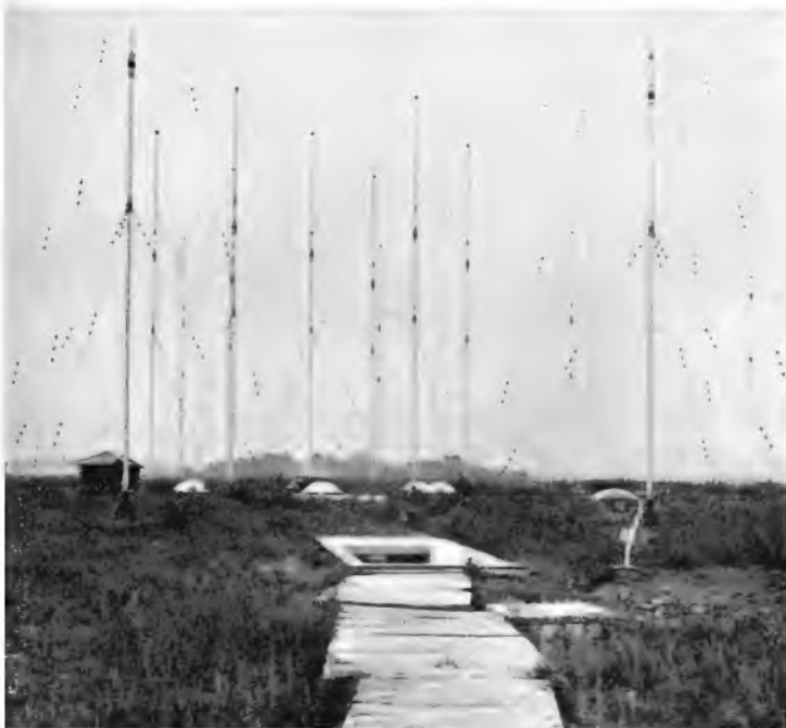
Bild 1. Die 19 Masten von je 8,5 m Höhe bilden die Antennenanlage. Vorn der Einstieg zu dem unterirdischen Empfangsgebäude, von dem sonst nur sechs Lichtkuppeln sichtbar sind
