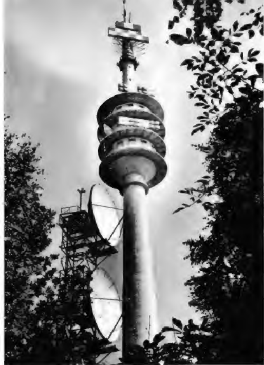
Der neue Fernmeldeturm auf dem Schäferberg in Berlin-Wannsee ist mit 212 m das höchste Bauwerk Berlins. Links die seit 1959 im Betrieb befindlichen Parabolspiegel (siehe auch unser Titelbild). Aufnahmen: Ernst Schwahn
