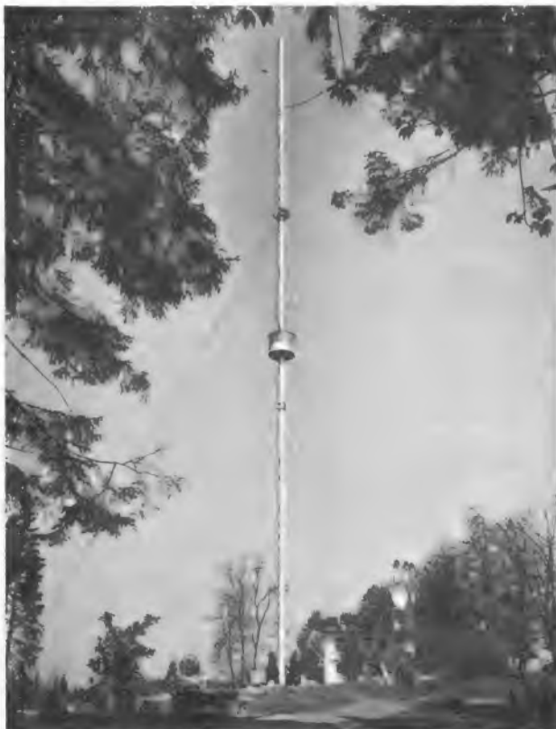
Bild 1. Der erste Fernsehsender in der Schweiz in seiner jetzigen Ausbaustufe: Uetliberg bei Zürich, Kanal 3
