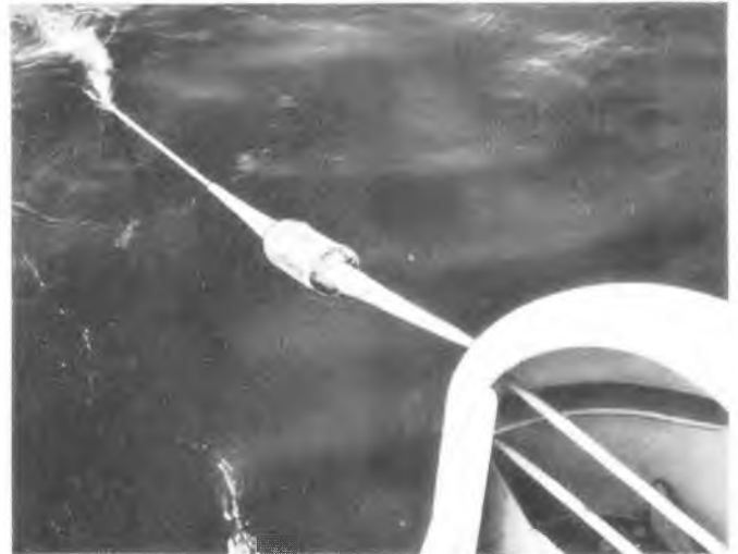
ICECAN Verstärker während der Legung
