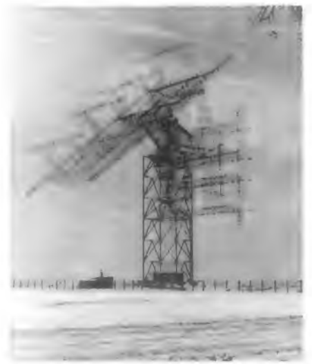
Bild 6. Dreh- und schwenkbare Kurzwellen-Richtantenne für den Wellenbereich 16...52 m mit 42 m hohem Trageturm
