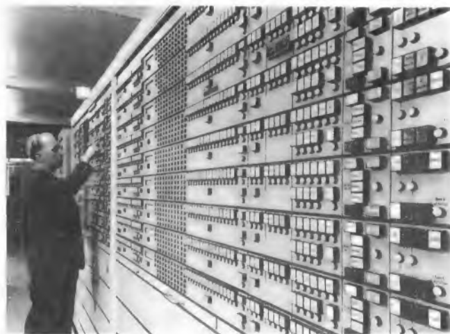
Bild 5. Neuer fernbedienbarer Antennenwahlschalter vom Typ Telematrix mit elf Sendereingängen und fünfzehn Antennenausgängen. Links zusätzliches Feld für Handbedienung
