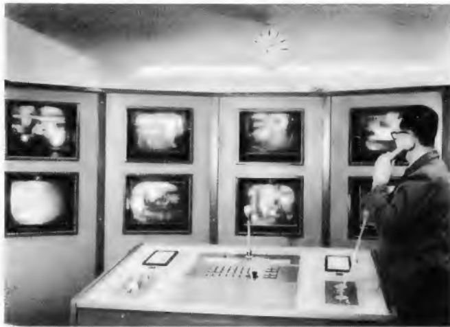
Auf den Bildschirmen der Philips-Kontrollgeräte überwacht der Schaltwart den Transport und die Verteilung der Pakete auf der 3,8 km langen Förder- und Verteileranlage des neuen Paket-Postamtes in Hannover
