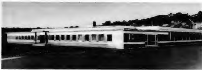
Das neue Daystrom-Werk in Sprendlingen
