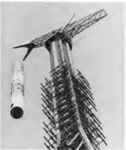
Bild 1. Montage einer Fernseh-Sendeantenne für den Bereich IV auf dem Monte Venda in Italien. Das 22 m lange selbsttragende Kunststoffrohr wurde fertig montiert auf die Spitze des Mastes gehoben
