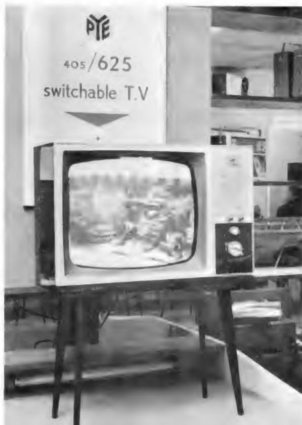
Bild 1. Der erste umschaltbare Fernsehempfänger 405/625 Zeilen mit 48-cm-Bildröhre (Pye)
