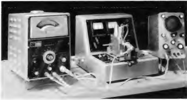
Bild 4. Prüf- und Abgleichplatz von Telefunken für NSF-Tuner
