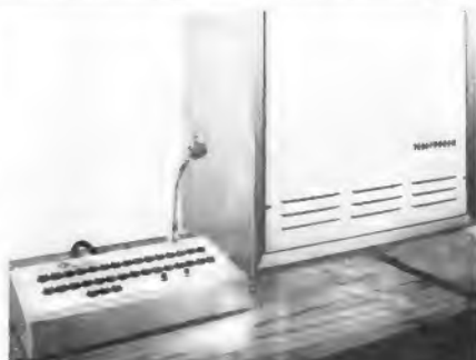
Die Zentrale der drahtlosen Personenrufanlage von Telefunken; bis zu 210 Teilnehmer können angeschlossen werden
