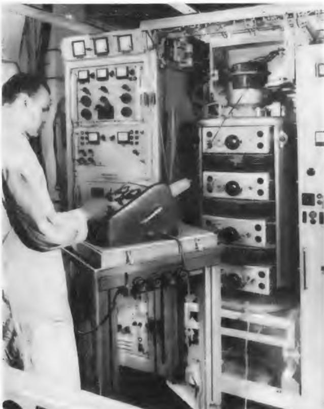
Zu diesem Bericht unseres Berliner Korrespondenten gehört auch das Titelbild des vorliegenden Heftes, das den Röhrenwechsel bei der Endstufe eines UKW-Senders mit einer Leistung von 10 kW zeigt
