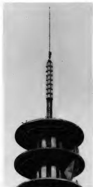
Bild 6. UHF-Sendeantenne auf dem Fernmeldeturm Hannover ( G = 25 )
