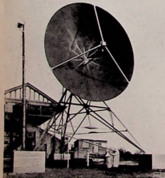
18-m-Parabolspiegel für Weitübertragung
