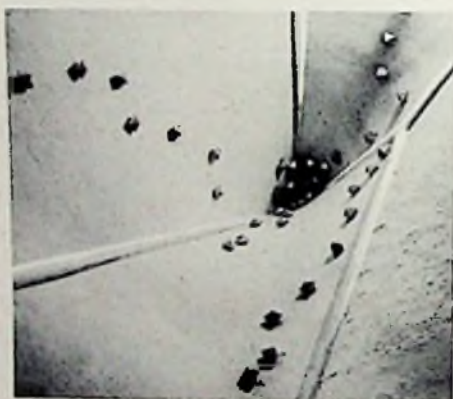
Bild 2. Bis in die Spitze beider Türme reichen die „Lautsprecherwege“ aus Mittel/Hochtonlautsprechern für die Wiedergabe der elektronischen Musik und der Geräusche, eingehüllt in staubsichere, schalldurchlässige Hüllen
