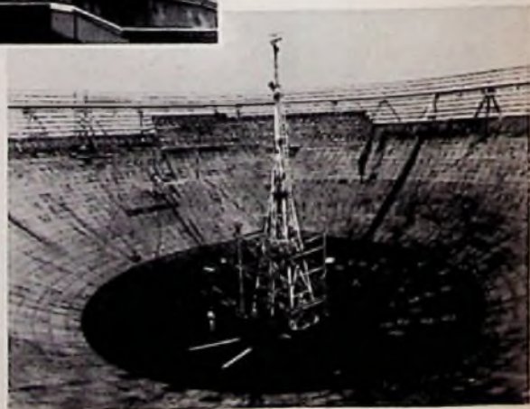
Bild 2. Dieses Bild gibt einen Eindruck von der Größe des Radioteleskops. Die Aufnahme entstand während der Montage des Antennenträgers, eines Mastes von 18 m Länge, und der Belegung des Schalengerüsts mit 7000 Stahlplatten
