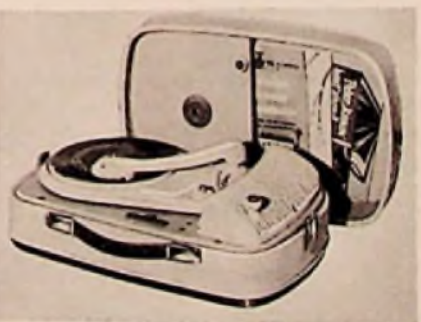
Bild 3. Das Unterteil des schnittliger gebauten PE Musical 2 V (Perpetuum-Ebner) enthält Phonochassis, Lautsprecher und Verstärker, während ein Vorrat von zehn bis zwölf 45er-Platten im Deckel untergebracht werden kann
