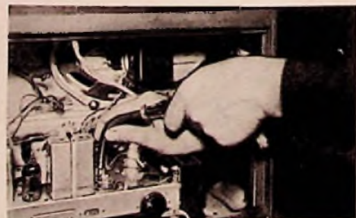
Bild 9. Unzugängliche Schrauben lassen sich mit diesem wassersollierten Schraubenzieher mit biegsamem Schaft bequem lösen. (Friedrich Damm, Remscheid)
