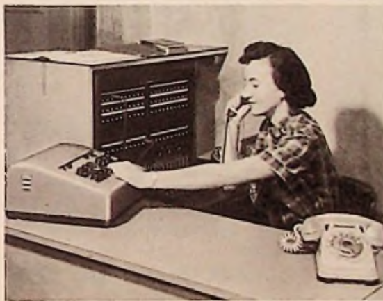
Bild 1. Modulationsgerät mit Zahlencodiereinrichtung für den Pagemaster-Sender in einer Fernsprechzentrale
