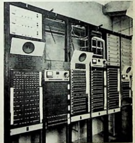
Zahlreiche Kreuzschienenverteiler im Schaltraum enthalten die Verbindungsmöglichkeiten für rund 200 Mikrofon- und Reporterplätze
