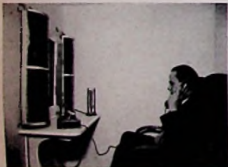
Bild 2. Blick in die Fernsprechzelle Berlin am Tage der Eröffnung (1. März 1936). Hinter den beiden Schutzkörben waren die Großflächen-Fotozellen mit angebauten Sekundärelektronen-Vervielfachern untergebracht
