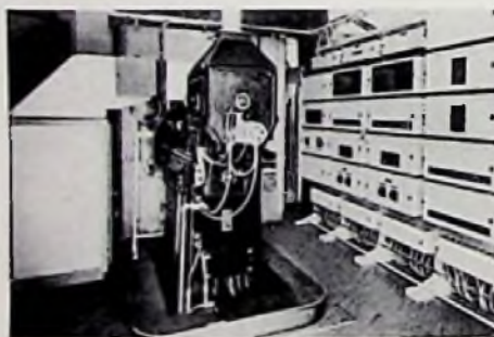
Bild 3. Technische Einrichtung der Fernsprechzelle. In der Mitte Nipkowscheiben-Abtaster mit 120-A-Bogenlampe, rechts Sendeverstärker- und Kontrollgestelle
