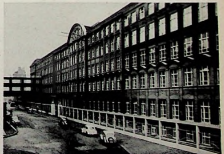
Das Wernerwerk I in Siemensstadt in seiner gegenwärtigen Form. Links der Übergang zum Wernerwerk-Hochbau
