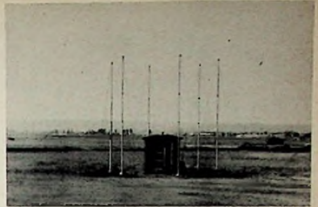
Bild 11. Sechsmast-Kurzwellen-U-Adcock mit unterteilten Masten von Telefunken
