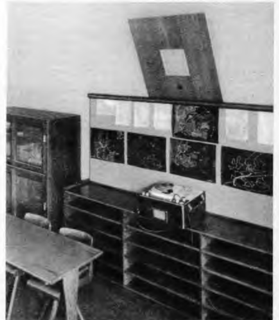
Bild 2. Lautsprecher-Anordnung an der Klassen-„Rückwand“. Schallwand (Staudigl) mit Lautsprechersystem (Wigo PMH 245/25) und Lautstärkereglern (Preh-L-Glied 10 Watt). Unten Magnettongerät (Ihle-Phonorex) (Aufnahmen: Willi Beutler, Hamburg)
