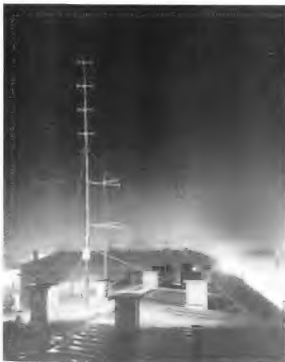
Mit dieser Kathrein-Vierebenen-Antenne wird im Zentrum von München der Fernsehsender Feldberg im Taunus empfangen. Unten am Mast der wasserdicht gekapselte Antennenverstärker
