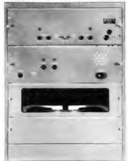
Bild 3. Automatisches Zeitanzeigegerät für Telefonzentralen (Assmann GmbH)
