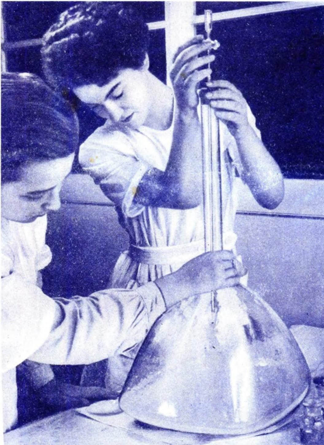
Eine beinahe heilige Handlung stellt das Auftropfen der Kollodium-Lösung auf die Wasseroberfläche im Bildröhrenkolben dar. Es ist dies einer der wichtigsten Arbeitsvorgänge bei der Herstellung metallisierter Bildröhren.
