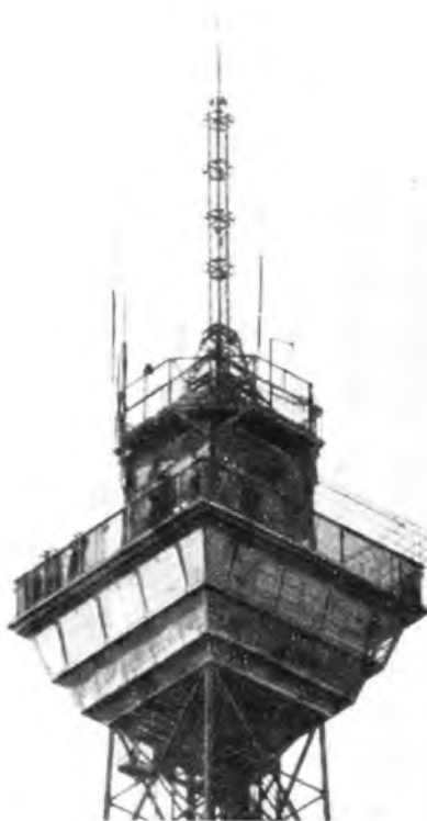
Die Spitze des Funkturms mit der Vierring-Antenne für den am Fuß des Turms aufgestellten 3-kW-UKW-Sender Berlin-Witzleben. Die Stabantennen an der Brüstung der obersten Plattform gehören zum Berliner-Polizeifunknetz (Foto NWDR.)
