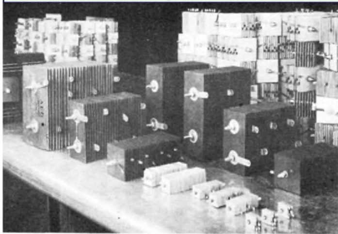
Bild 1. Verschiedene AEG-Selen-Gleichrichter
