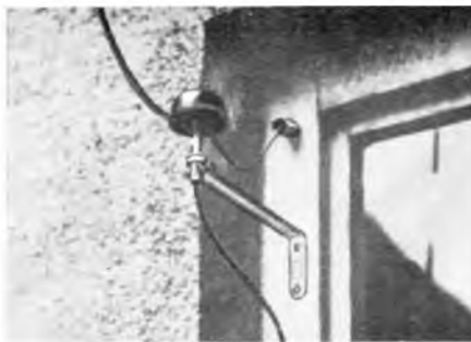
Bild 8. Blitzschutzanordnung mit Bandableiter
